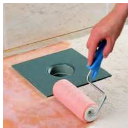
Appliquer le primaire d'accrochage directement sur la dalle béton et laisser sécher
