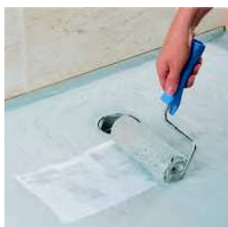
Appliquer de nouveau de l'étanchéité liquide
