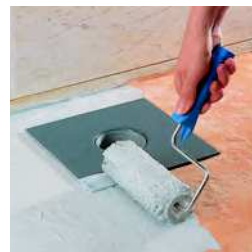
Appliquer l'étanchéité liquide (1)
