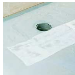
Afin d'éviter les microfissures, mettre en place des bandes d'accrochage
