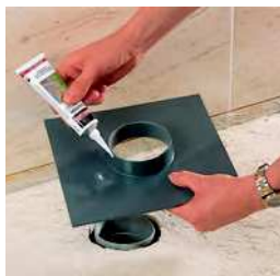
Coller la platine d'étanchéité dans le corps du siphon
