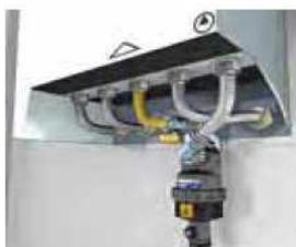
Spécialement conçu pour protéger les chaudières murales, le DIRTMAGSLIM recueille les impuretés dans sa chambre de décantation de grande taille, ainsi que les particules ferreuses grâce à son anneau magnétique.
